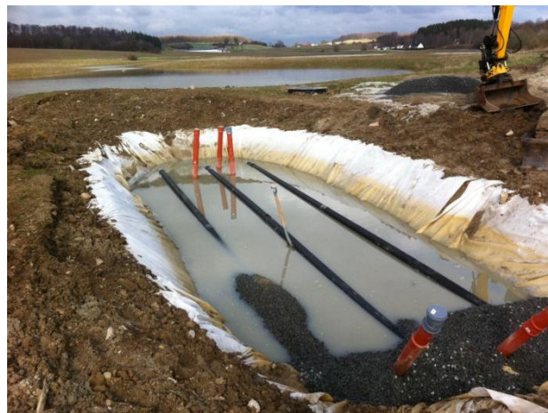
Figur 22: Dräneringsrör utlagda i makadamskiikt ovanpå kalkfiltermaterialet.
