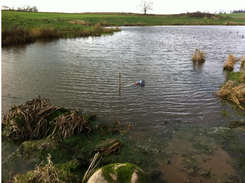
Figur 29: Inlopp till kalkfiltret vid Stora Markie med skyddande sil.
