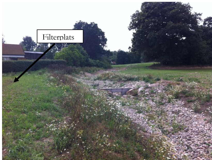
Figur 18: Utskovet från våtmarken och till vänster filterplatsen. Vatten leds från diket strax uppströms (bitom) utskovet i rör till filtret, och från filtret åter i rör tillbaka till diket 15 m längre nedströms.
