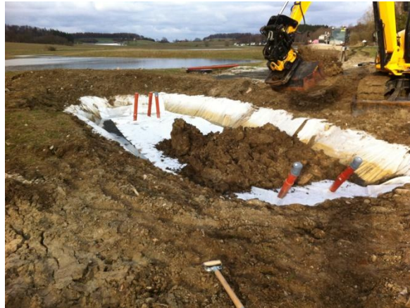
Figur 23: På makadamen lades först geotextilduk, därefter 80 cm jordlager.
