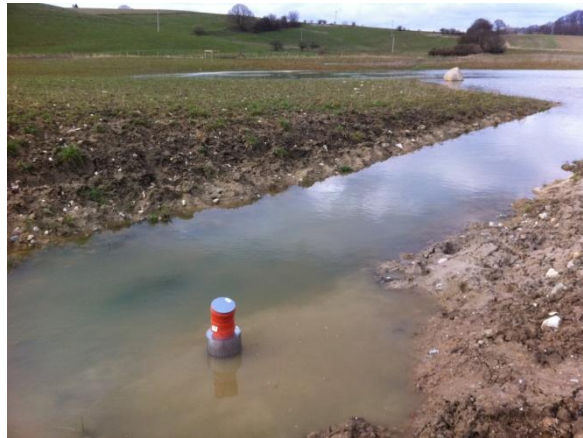
Figur 21: Inlopp till kalkfiltret med skyddande sil.
