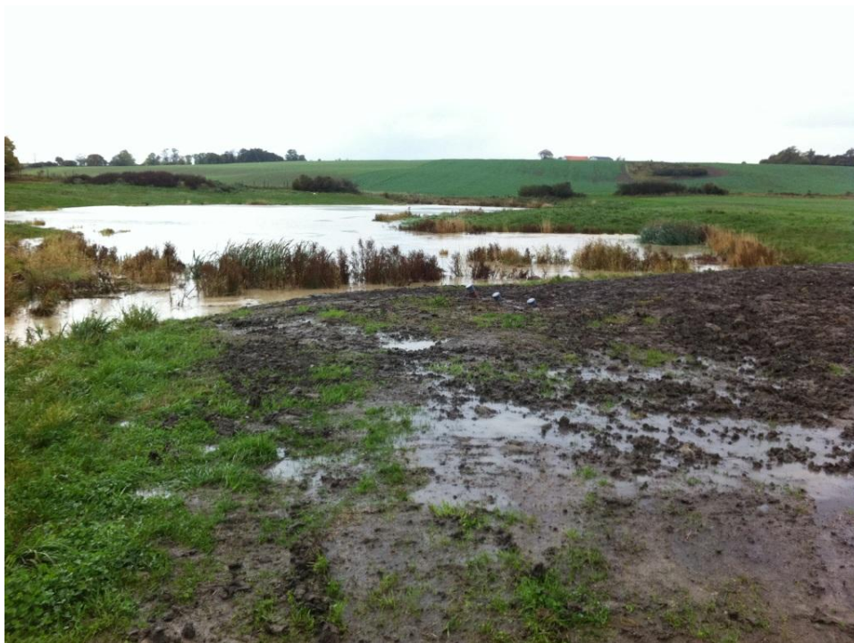
Figur 30: Kalkfilterbädden vid St Markie efter övertäckning. Mitt i bilden syns stigarrör som sticker upp några decimeter över marknivå.
