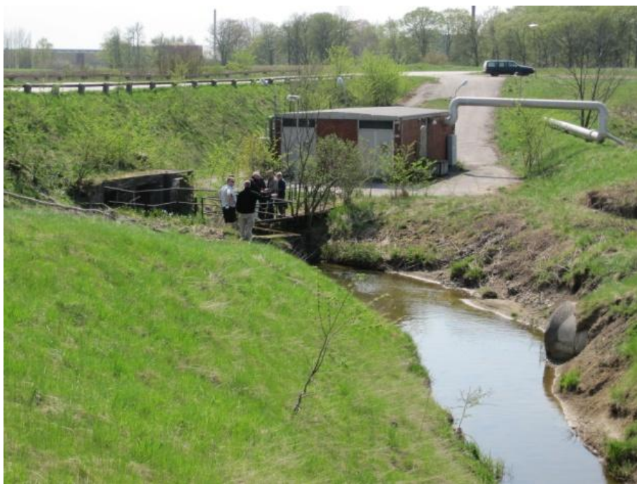
Figur 3: Mätstationen vid Sockerbruket
